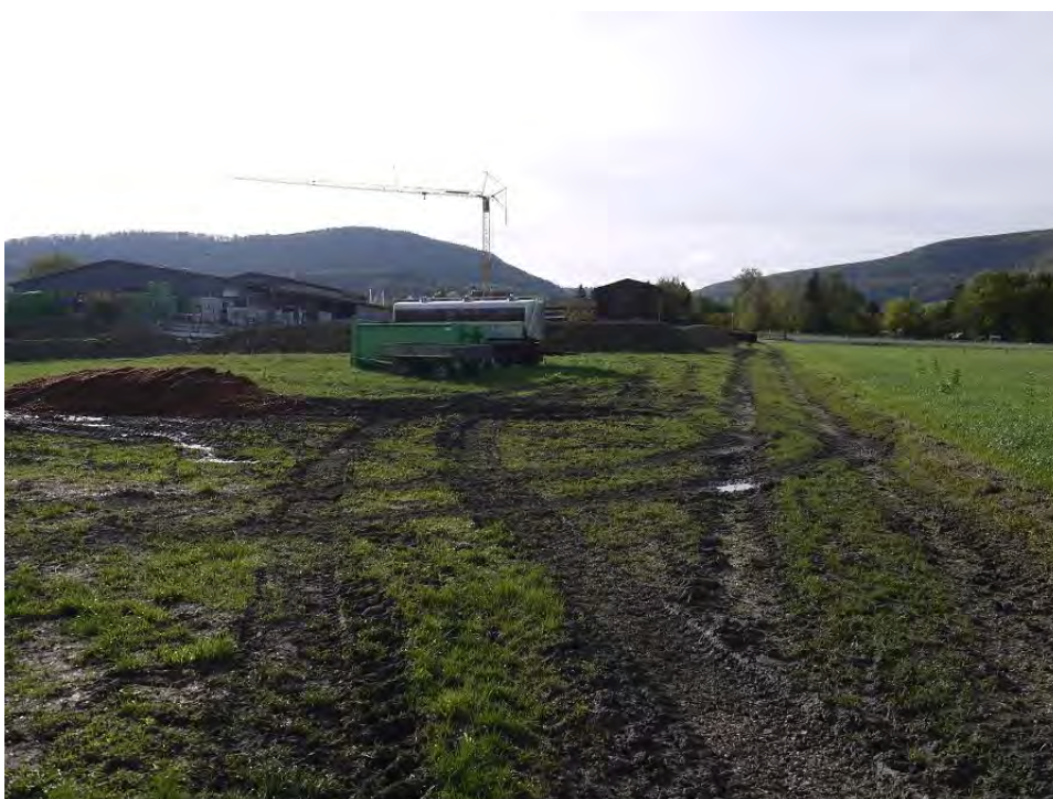
Abbildung 9 – Witterungsbedingt sind deutliche Fahrspuren zu sehen, die auch teilweise wassergefüllt sind durch die vielen Niederschläge im Oktober
